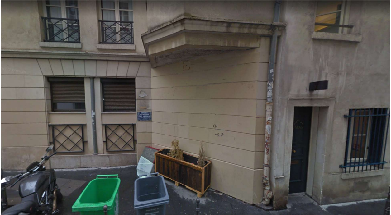
Rue Vauvilliers, Paris
